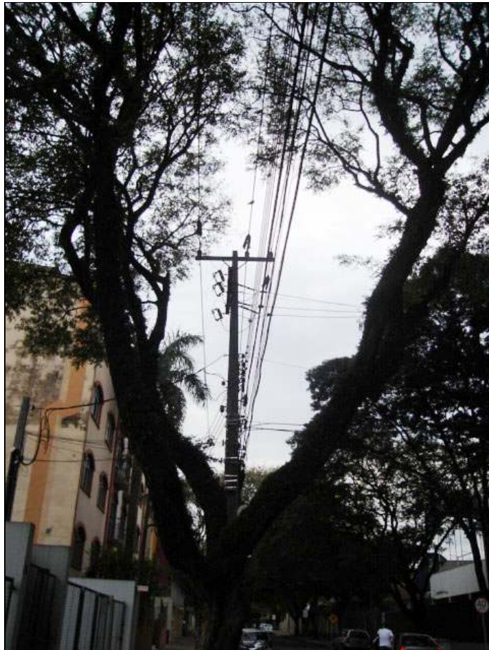
Figura 4.4 Poda em “v” necessária para a rede aérea convencional
